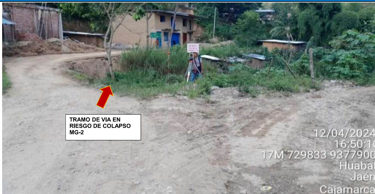
FIGURA N°01: TRAMO CRÍTICO DE LA RUTA CA-744. SE APRECIAN DESLIZAMIENTOS Y REDUCCION DE LA CALZADA Y PUENTE EN PELIGRO.
